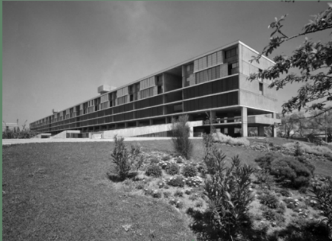
Fig. 4. Vista general Unidad Vecinal Portales. Bloque habitacional y espacios comunes.
