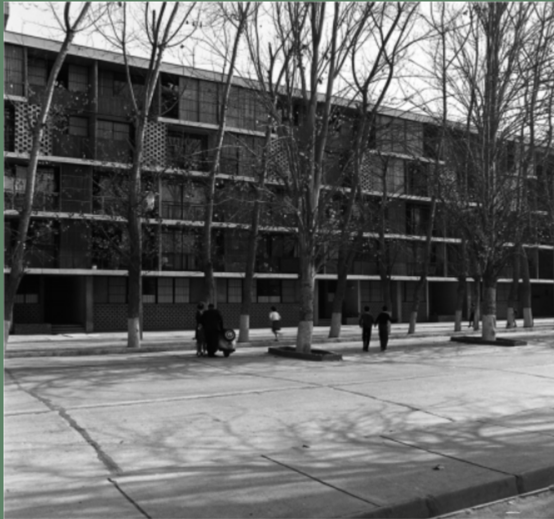
Fig. 6. Vista del Conjunto y su relación urbana con la vegetación y espacios de circulación peatonal proyectados. © Archivo de Originales SLGM. FADEU. Pontificia Universidad Católica de Chile. Fondo Documental René Combeau T.
