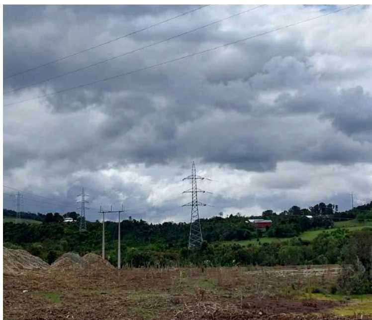
Figura 14: Torres de transmisión eléctrica de SAESA en comunidad Alto Fundo de Gamboa.
