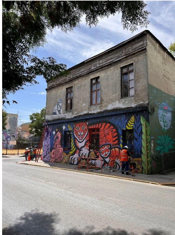
Casa Fachada Completa en restauración. Compañía de Jesús #2885, Barrio Yungay
