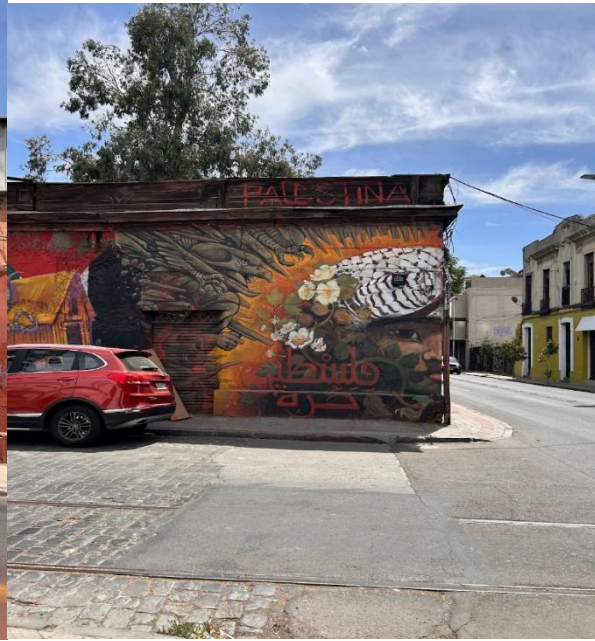
Casa en Desuso semi destruida. Compañía de Jesús #2474, Barrio Yungay
