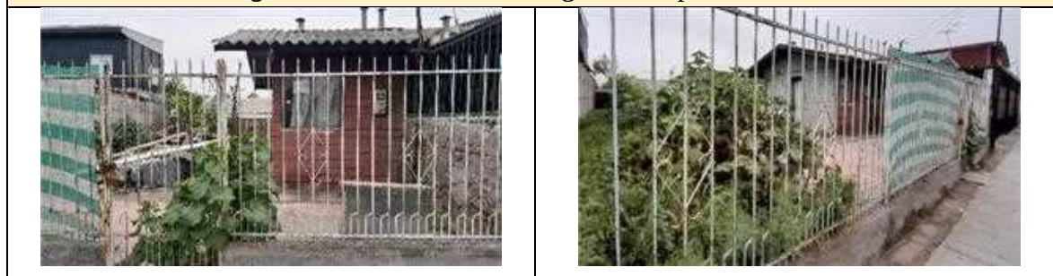
Figura 3. Casetas básicas originales, Operación Sitio.
