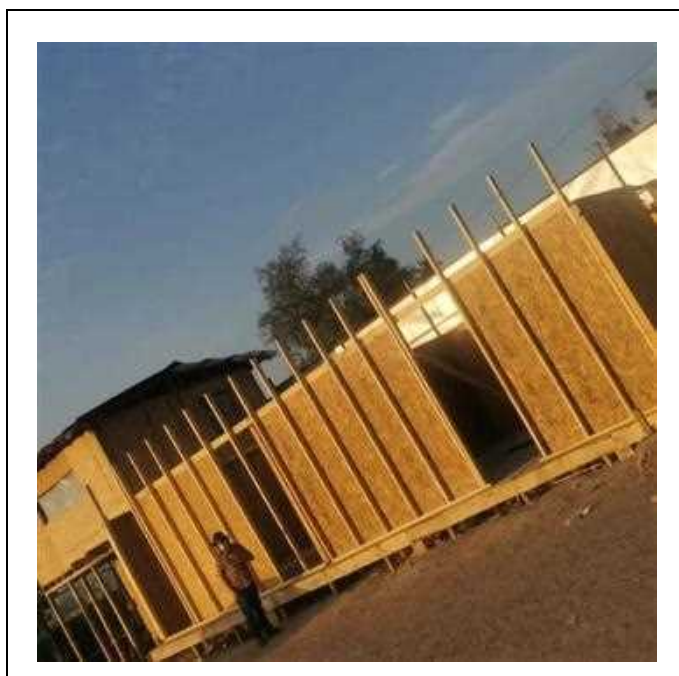
Figura 16. Construcción Escuela Dignidad
