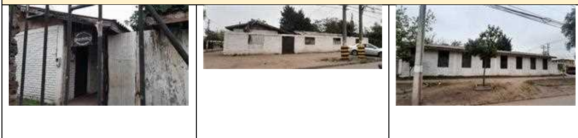
Figura 18. Sede “Junta vecinal A-41 Casas Básicas”.
