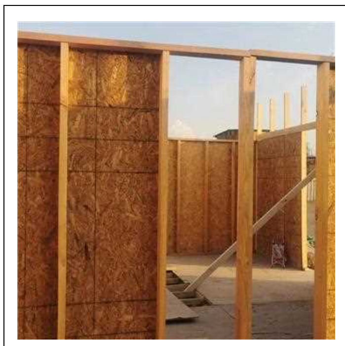
Figura 17. Construcción Escuela Dignidad
