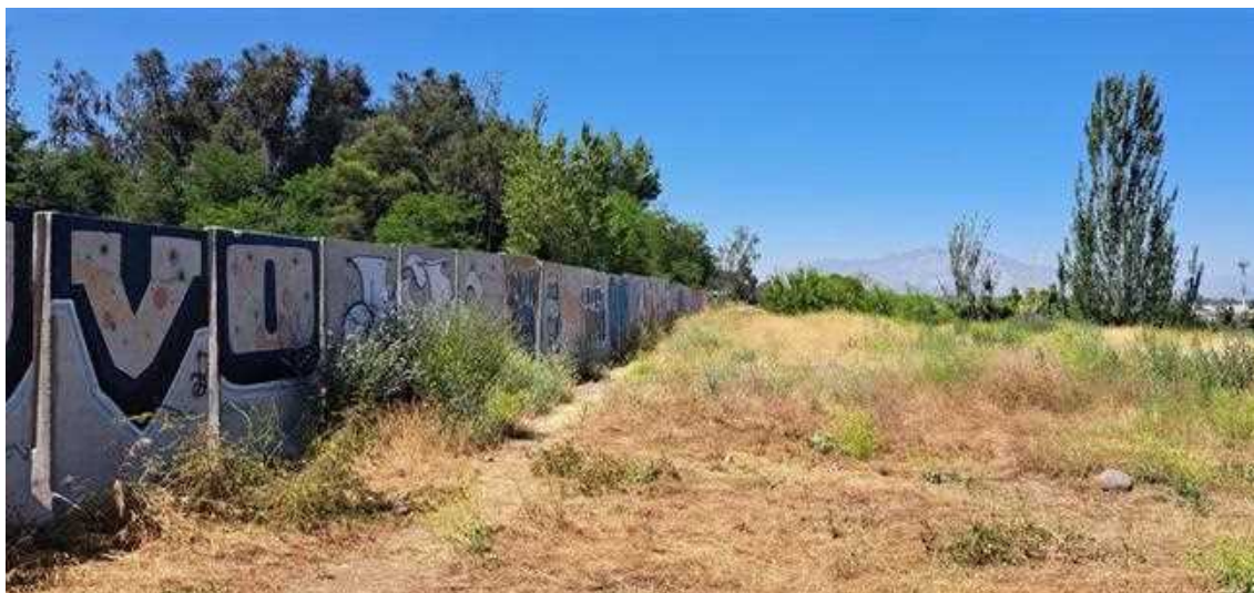
Foto N° 6: Divisiones de cemento utilizadas como “pizarras” para pintar, Puente Alto.
