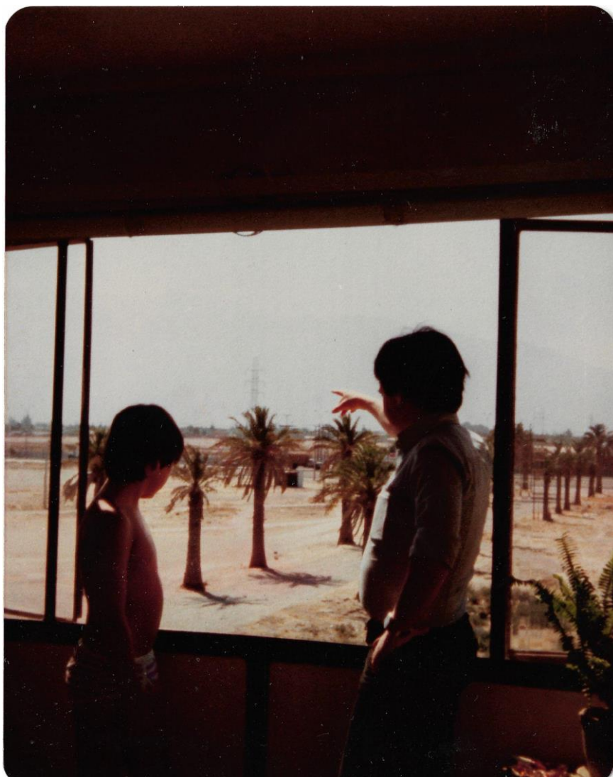
Paisaje en construcción, equipamiento municipal.(Sector Parque Violeta Parra) , (1984) Archivo de la Familia Muñoz.
