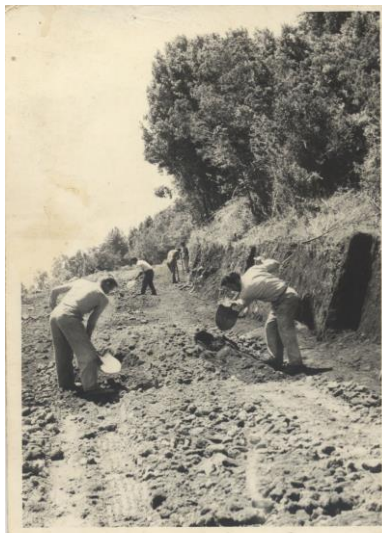
Figura 10. Obreros trabajan en el camino a Riñinahue. (1978)
