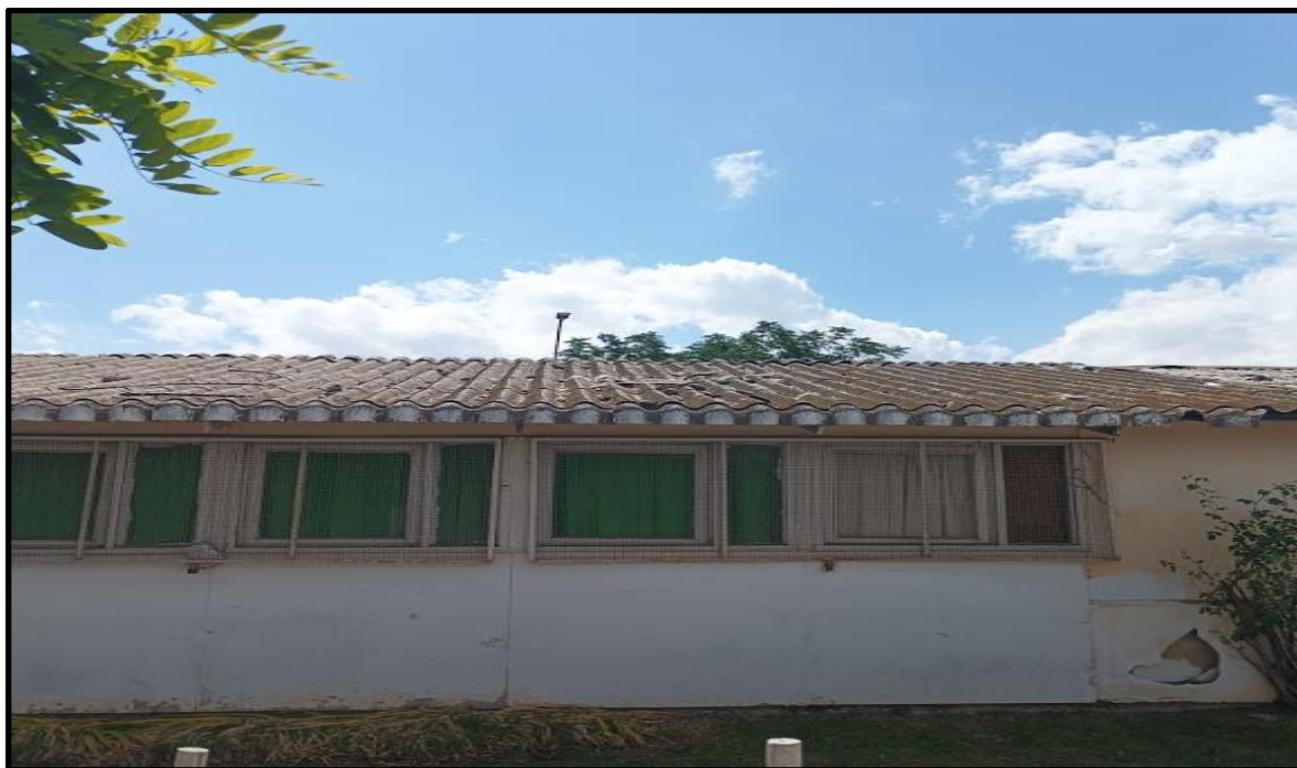
Imagen N°1: Techumbre Continua de Asbesto.
