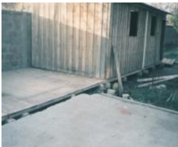
Ilustración N°13: Mediagua instalada en ex Nido 18
