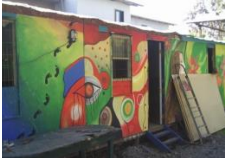
Ilustración N°27: Mural en fachada de oficina
